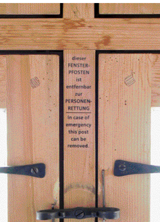
Wasserflecken und Abrieb auf der rohen Lärche unterstützen den Eindruck von Alter. Der mittlere Pfosten kann für die Personenrettung entfernt werden.
