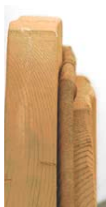
Oberer Falz einer Brandschutztür. Sie widersteht dem Feuer über eine Dauer von 30 Minuten.
