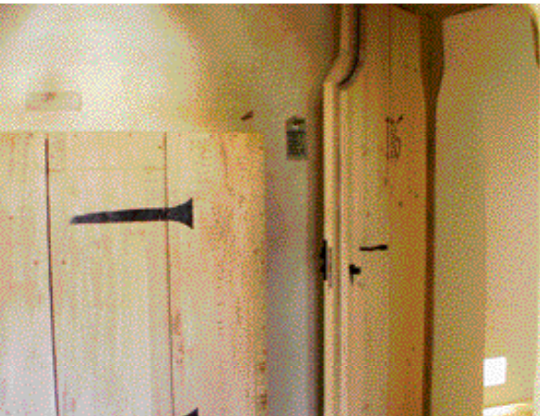
Die Zimmertüren sind wie die Brandschutztüren auch aus Fichte und haben Lederdichtungen.
