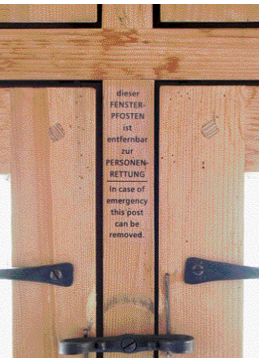
Wasserflecken und Abrieb auf der rohen Lärche unterstützen den Eindruck von Alter. Der mittlere Pfosten kann für die Personenrettung entfernt werden.
